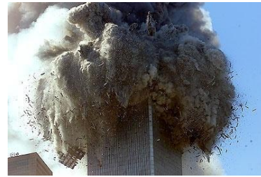
Figure 3: Destruction de la Tour Nord - Vue latérale
